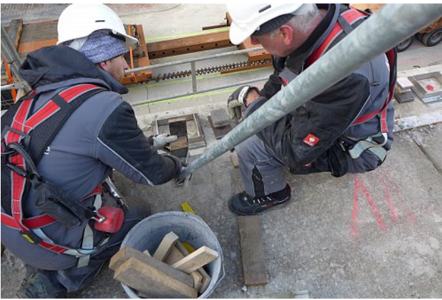
Vorbereitung: Die Lager, auf denen die Brücke ruht, wurden noch gestern mit einem hochfesten Spezialmörtel vergossen. | © Hans-Hermann Igges
