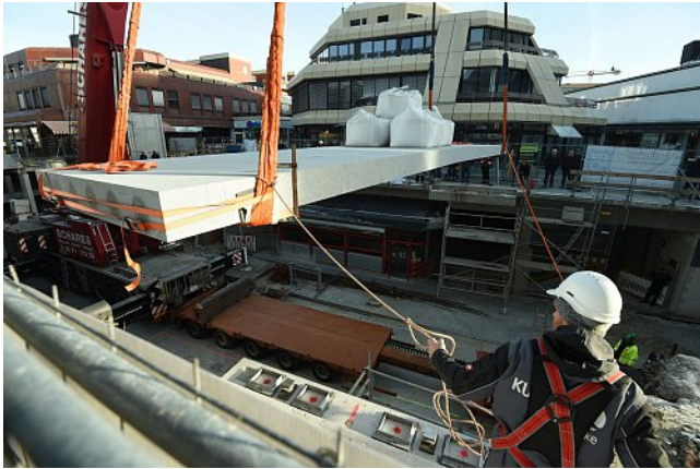
Am Kran: Die Granitbrücke wurde ganz sachte in die richtige Position gebracht. | © Marc Köppelmann
