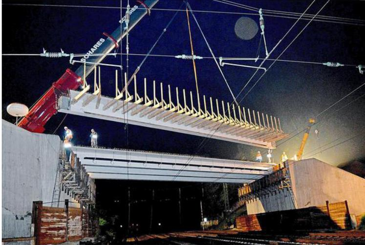
**Oelde - Es war ein nächtlicher Kraftakt – und Millimeterarbeit. Der Neubau der 100 Jahr alten Eisenbahnbrücke an der Kreisstraße 13 in Oelde über die viergleisige Strecke zwischen dem Ruhrgebiet und Hannover ist einen entscheidenden Schritt vorangekommen.**
